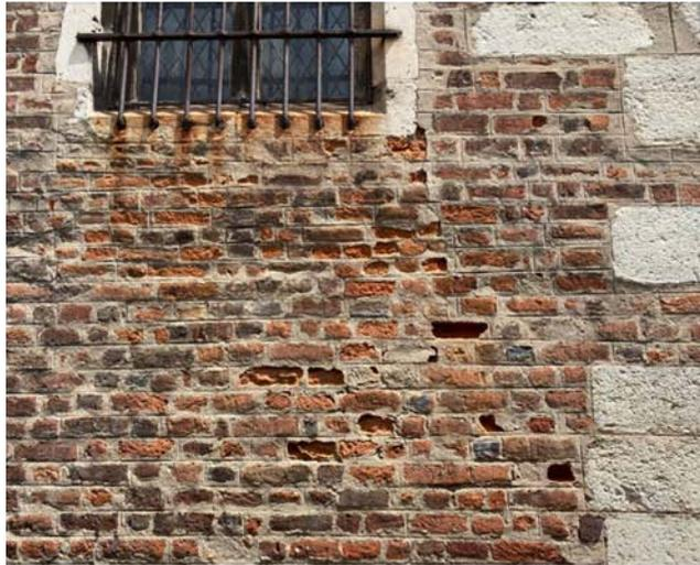
Parement courant, en carrons. Etat de conservation moyen à mauvais. Érosion avec perte de matière, joints tardifs tirés au fer, encrassement généralisé.
