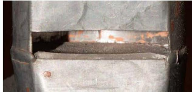
Déformation symptomatique d'un biseau en plomb trop malléable. Oxydation.
